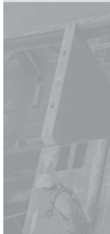
Figur 15 Innfesting av bjelken til søylen med slisseplate.
