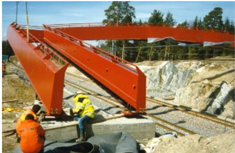
Selvstabiliserende brobjelke til en bro i Bålstad i Sverige presentert av Teknisk Direktør Anders Granstrøm fra Best betong- og stålkonstruksjoner AB i sitt foredrag om Ny teknikk i stålbygget
